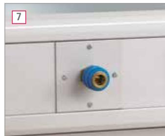
**7 Druckluft-Anschlussdose 1PE**
