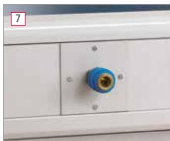
**7 Druckluft-Anschlussdose 1PE**
